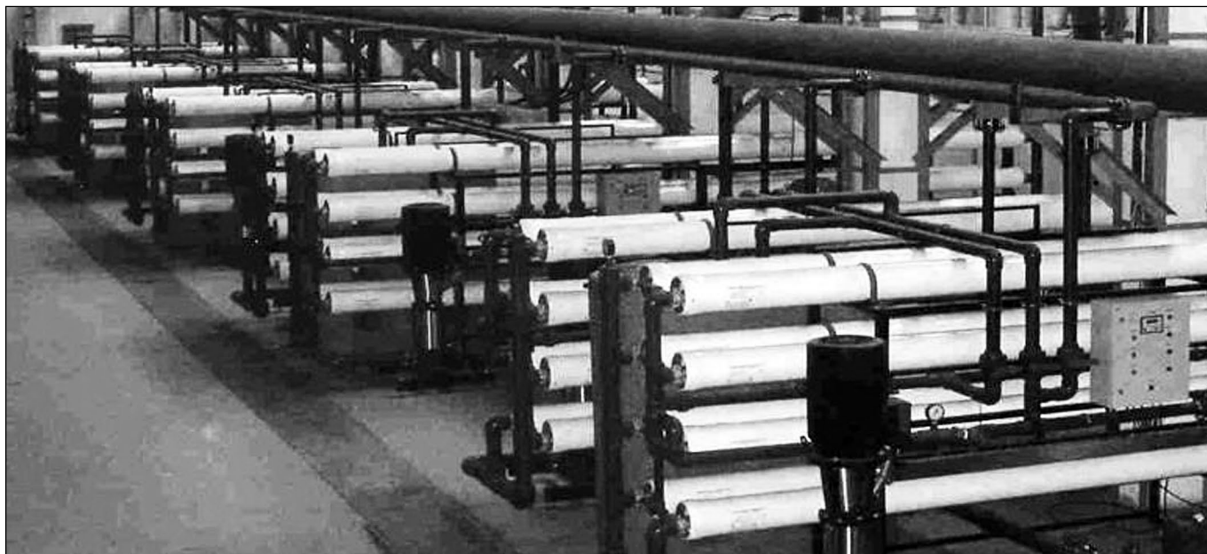
Рис. 8. Подготовка питьевой воды на заводе обратноосмотического опреснения каспийской морской воды.
