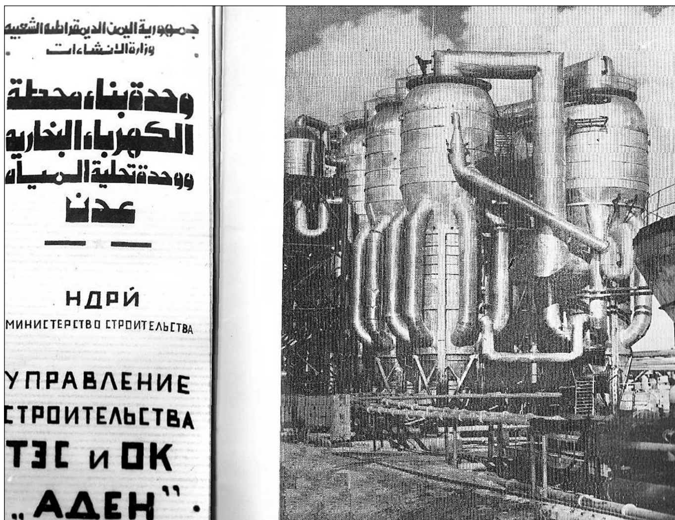
Рис. 9. Десятикорпусная опреснительная установка в г. Адене (Йеменская Республика).
